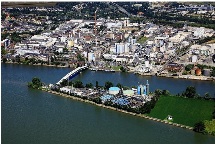
Der Industriepark Wiesbaden mit der vorgelagerten Petersaue, auf der sich die Biologische Abwasserreinigungsanlage befindet.
