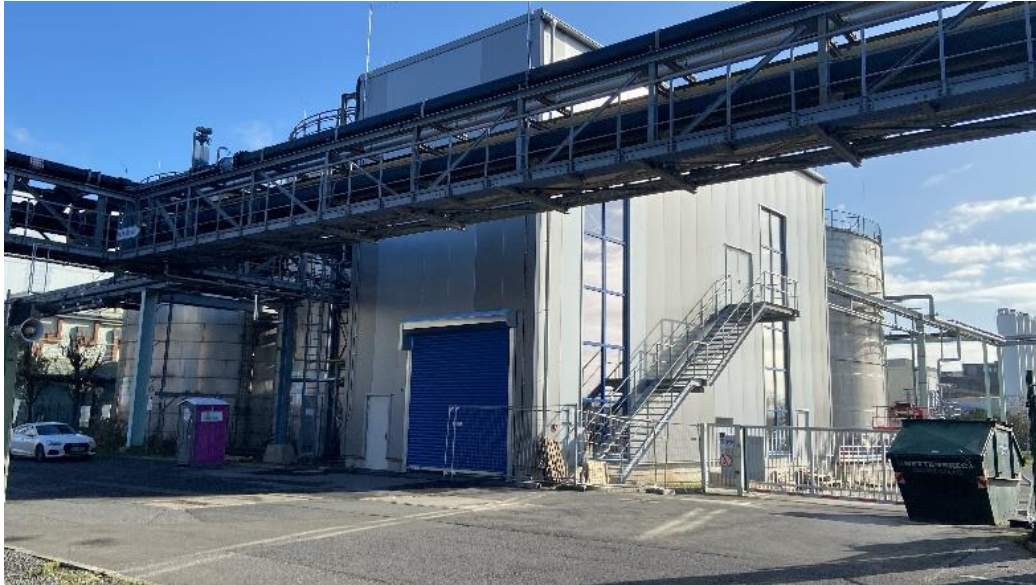
Außenansicht der neuen ISW-Dünnschlammmentwässerungsanlage mit Zufahrtstor.
