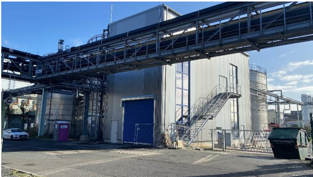
Außenansicht der neuen ISW-Dünnschlammwässerungsanlage mit Zufahrtstor.
