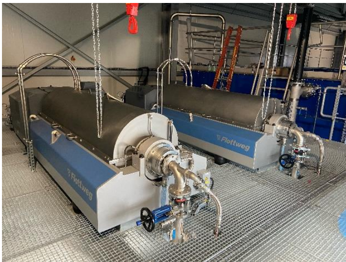
Die beiden Dekanter zur Dünnschlammwässerung im Obergeschoss des ISW-Betriebsgebäudes.
