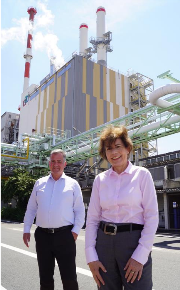
Jörg Kreutzer und Cornelia Lentge (Geschäftsleitung InfraServ-Wiesbaden-Gruppe), vor dem neu errichteten Kesselhaus des GuD-Kraftwerks im Industriepark Wiesbaden.
