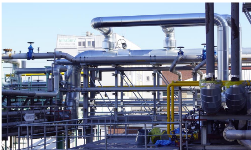
Blick vom äußeren Treppenaufgang des neuen GuD-Kraftwerks in Richtung des ISW-Verwaltungsgebäudes im Industriepark Wiesbaden.
