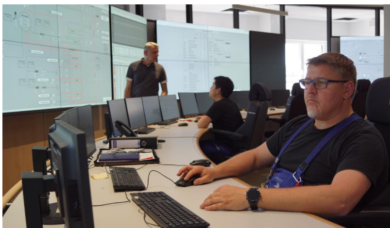
Das neue GuD-Kraftwerk im Industriepark Wiesbaden wird weitgehend digital von einer modernen Zentralwarte aus gesteuert.
