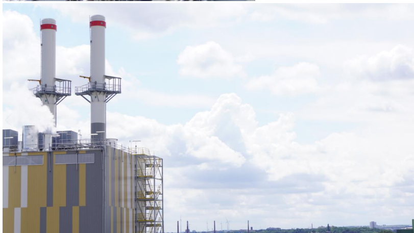
Das neue GuD-Kraftwerk im Industriepark Wiesbaden verfügt im neu errichteten Kesselhaus über zwei leistungsstarke Gasturbinen-Kessel-Kombinationen, deren Kamine 60 Meter in die Höhe reichen.
