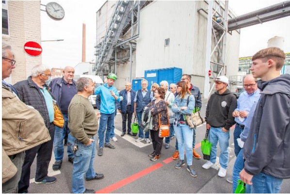
Diplom-Ingenieur Markus Schnitzler erklärt den Besuchern das 2021 in Betrieb genommene GuD-Kraftwerk.
