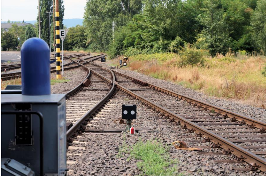
Anschluss der zum Industriepark Wiesbaden führenden Gleisanlagen an das DB-Streckennetz.
