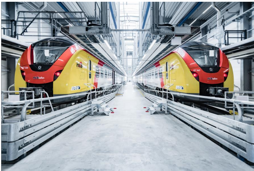
Schienenfahrzeugwerkstatt der Hessischen Landesbahn (HLB) im Industriepark Wiesbaden.
